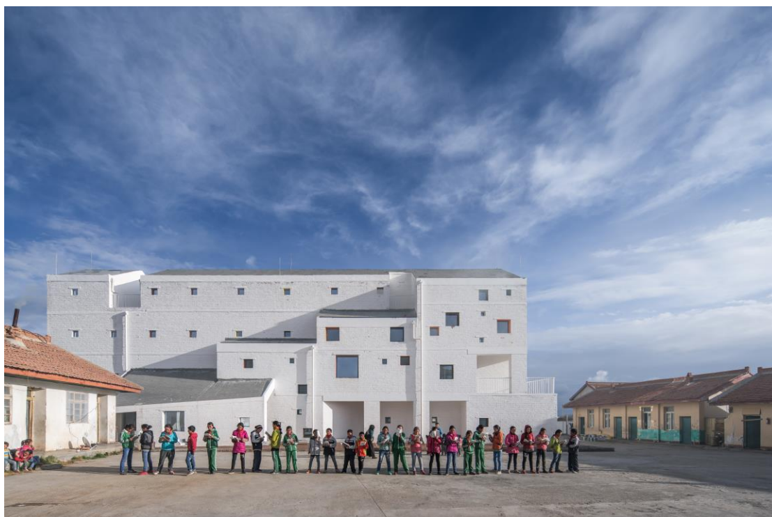
暖巢一号 摄影：存在建筑
